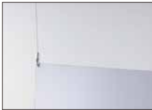
市販の吊り下げ金具取付
