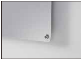
ネジ釘等で四隅を取付
